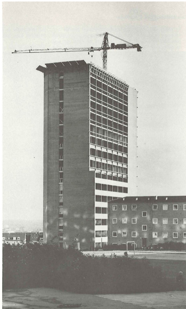
Højhuset set fra nordvest. Opholdsaltanerne i husets vestside er begrænset til de nederste 6 etager.
