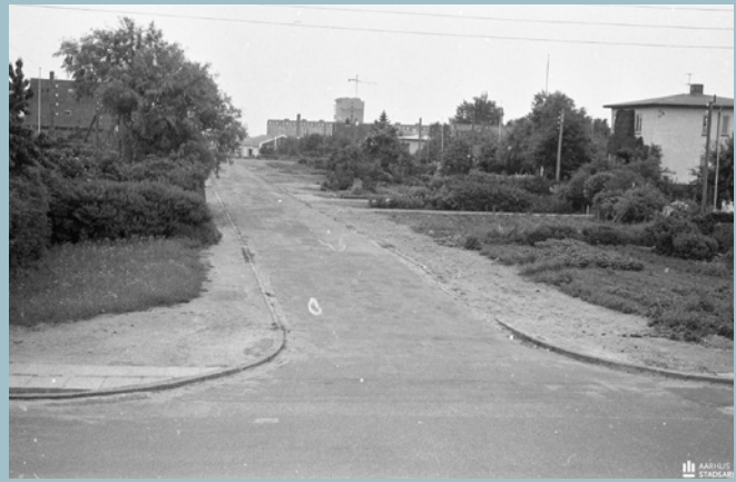
Møllevangs Allé med boligblokken på Fuglesangs Allé i baggrunden og højhuset på Charlotttehøj, Dybedalen 1-3 under opførelse.
